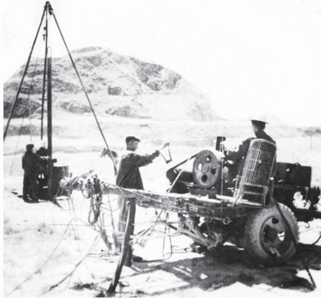
为了开发玉门油矿，在周恩来副主席的关心协调下，调运了延长油矿的两部钻机，此为1939年3月运抵玉门的第一部顿钻。
